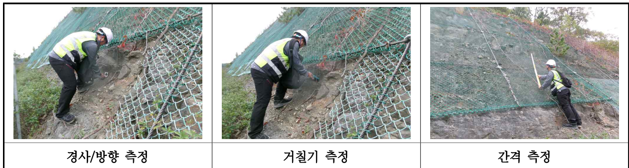
【사진 30.3.2】 불연속면 측정 현황
